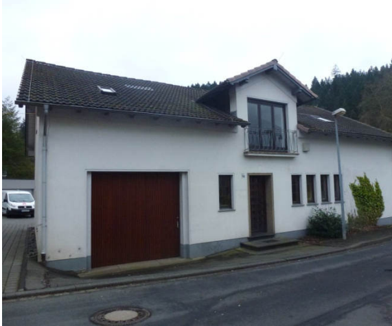
Das neue Haus Bahnhofstr. 14 a, 57548 Kirchen
